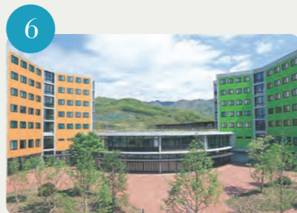
国際リベラルアーツ学部棟
